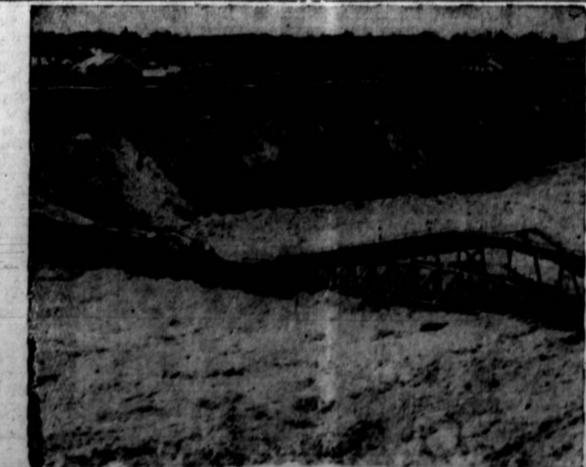
Slika kaže most pri Niagarskih vodopadih, ki se je porušil vled silnega pritiska lednih plošč.
