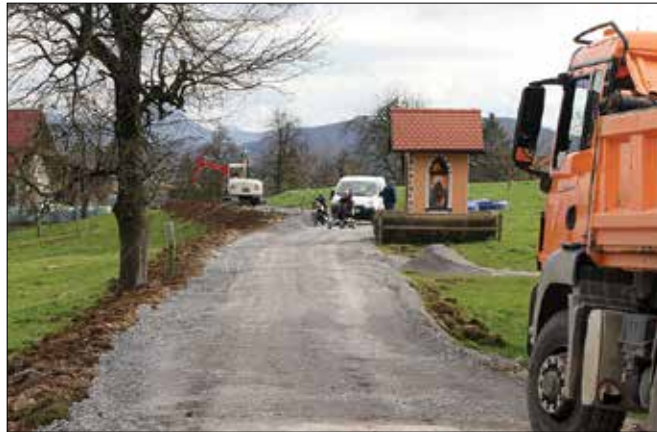
Z izvedbo modernizacije ceste med Mozirjem in Hudobrezniki bo sanirana dobra polovica mlečne ceste.
