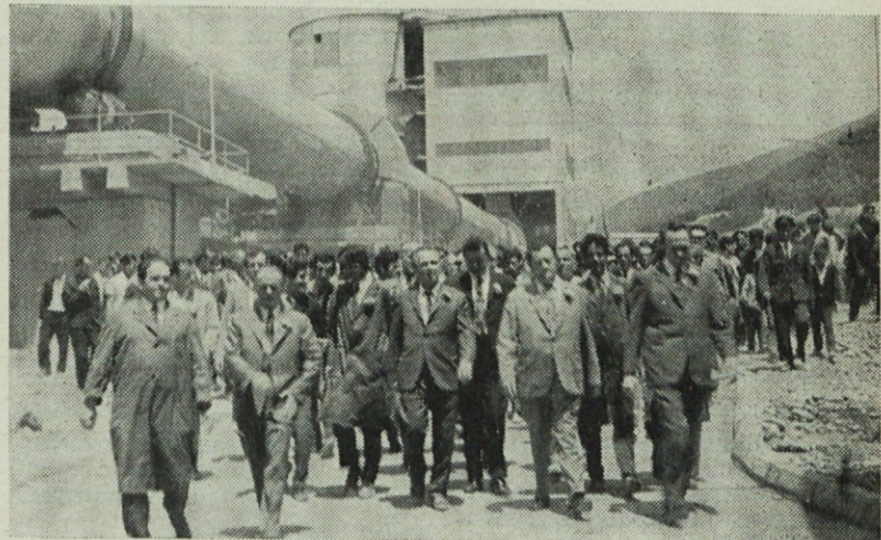
Gostje so se ustavili v vsakem objektu, generalni direktor cementarne Šar pa je s pritiskom na gumb spustil objekt v pogon. Goste so pričakovale skupine naših monterjev, ki so poskrbeli za vse potrebne predpriprave.
