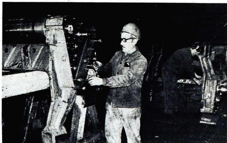
Vzdrževalca — ključavničarja pri montaži novega hladnega navijalca za valjarno štekel
