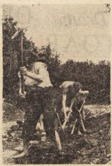
Delo na Brkinski cesti
