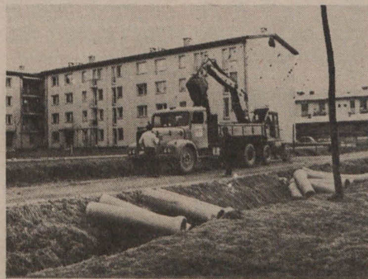
Iz dejavnosti Komunalnega podjetja Vič: v teku je polaganje kanalizacije v Trnovem.
