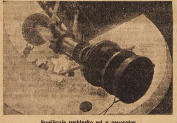
Spuščanje turbinske osi v generator
