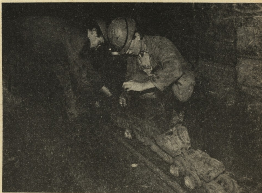
Popravilo verižnega tira pri glavnem jašku Ojstro
