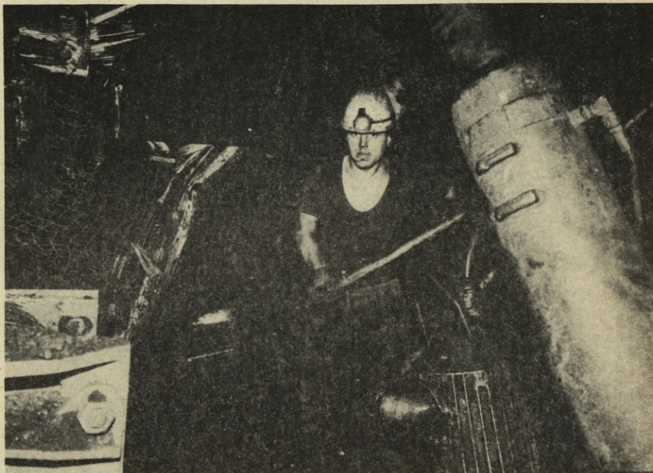
Ante Jurišič čisti prostor za črpalko na čelu Terezija II, kota 150
