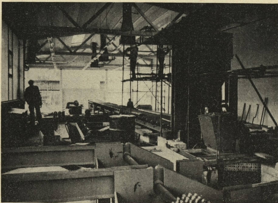
Montaža strojev v novi žagi na Rudniku Trbovlje.
