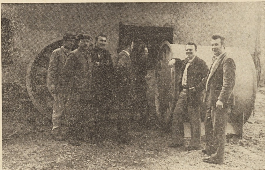
Ivan Škafar, Nande Mejač, Franci Mešetar, Srečko Klenovšek, Albin Pikl, Erik Poljšak in Milan Pungaršek pri novih ventilatorjih (izdelava Klima, Celje). Pri B jašku v Hrastniku bomo zamenjali dosedanje z novimi močnejšimi ventilatorji, stare pa vgradili na ventilatrosko postajo na Pleskem.
