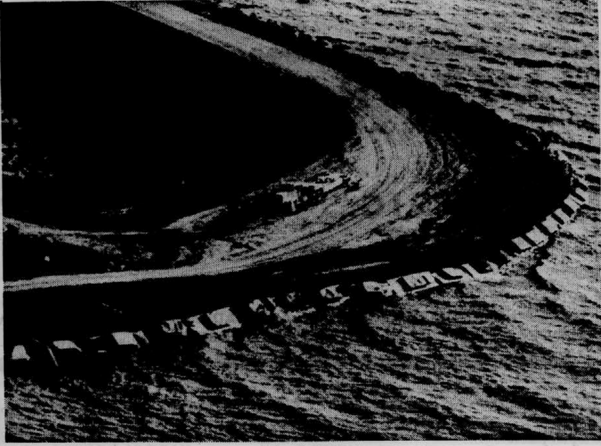
NENAVADEN GRADBENI MATERIAL — Dolgo vrsto tisočev zapuščenih avtomobilov so v Kaliforniji uporabili kot material, s katerim so okrepili obrambne nasipe pred naraščajočo vodo. Več kot 250 km 2 plodne zemlje v dolini jezera Tulare, ki je znana po tem, da je zelo suha, je letos že bilo pod vodo. Zda, ko se je začel v pogorju Sierra Nevada topiti sneg, pa so vode vdrle v dolino in jo groze poplavit. Na sliki: nenavaden zaščitni nasip. Telefoto: UPI
