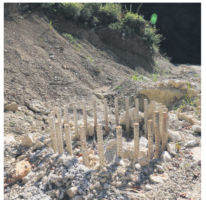
Tudi ogromni piloti na spodnjem in zgornjem delu plaz niso zaustavili plazenja zemlje. Potrebni bodo dodatni ukrepi.
