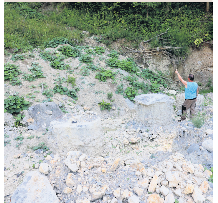
Tudi ogromni piloti na spodnjem in zgornjem delu plaz niso zaustavili plazenja zemlje. Potrebni bodo dodatni ukrepi.
