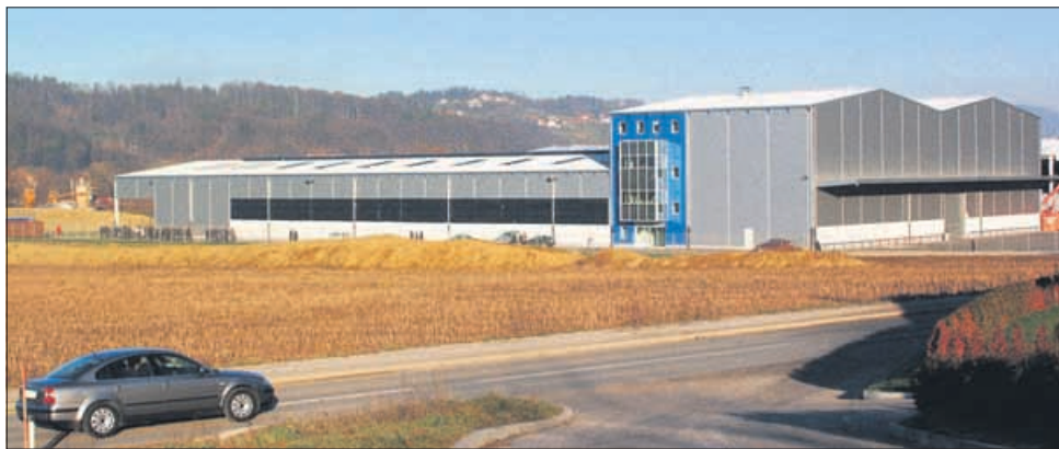
Alpos potrebuje visoko dokapitalizacijo. Sicer ... Glede na to, da je podjetje vse mesece kljub težavam redno izplačevalo plače, upanje, da ima uprava v rokavu še kakšnega aduta, ostaja.
