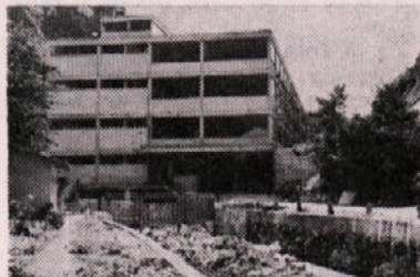
Skladišče in dodelava v Radečah. Največja težava je bila gradnja objekta nad obstoječo strugo hudournika Sopota.
