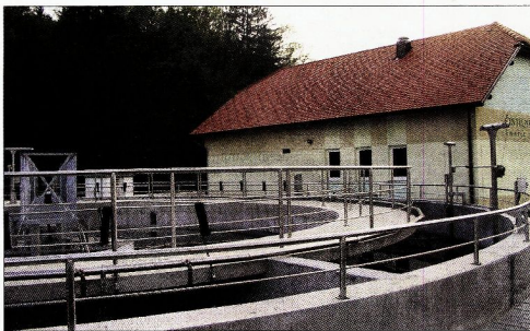
Po izgradnji objekta čistilne naprave in kolektorja v Šmarju pri Jelšah je letos na vrsti priključitev na kanalizacijo.
