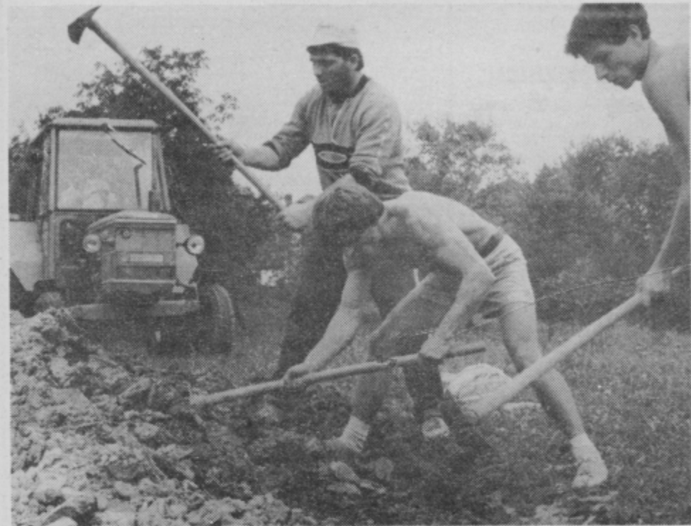
V Planinski vasi brigadirji pridno vihtijo krampe in lopate, ob našem obisku pa so zasipavali jarke za vodovod. Na pomoč so priskočili tudi domačini, ki so s traktorji utrjevali zemljišče.
