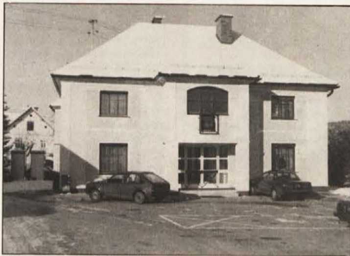
Obnovljena občinska hiša v Globasnici.
