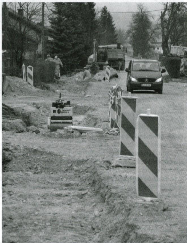
Obnovitvena dela na Rovtarski.
