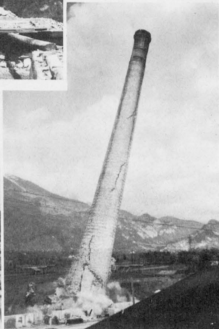
Spodaj: Velikanska 56 m visoka sveča se je začela nagibati. Med padcem so rasle razpoke po vsej dolžini dimnika, ki je z velikanskim grmenjem zbobnel naravnost tja, kamor so preračunali.
