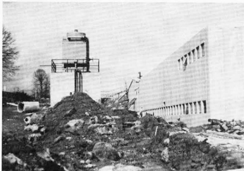
Gradbena dela novih proizvodnih prostorov v TOZD SUDEST, že zgrajeni!
