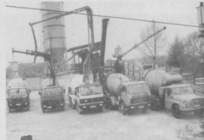
Strojni park podjetja Žiher: štirje avtomešalci za prevoz betona in cisterne za prevoz cementa v razsutem stanju.
