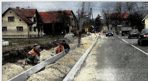
Pri gradnji pločnika so položili tudi cevi za meteorne vode.
