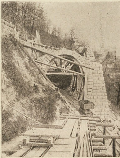
Zgradba belokr. železnice: Obokanje predora. (Po posebni fotografiji za Slov. Ilustr. Tednik.)
