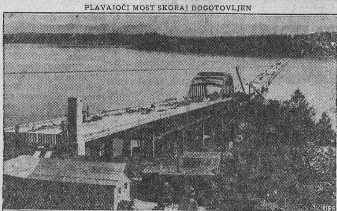
Preko Washington jezera, blizu Seattle, Wash., grade nov most, kateri bo nekaj svojevrstnega. Postavljen bo namreč na pontonih in bo torej dobesedno plaval na vodi. Most je skoraj dogotovljen ter bo slovesno odprt 2. ali 3. julija.
