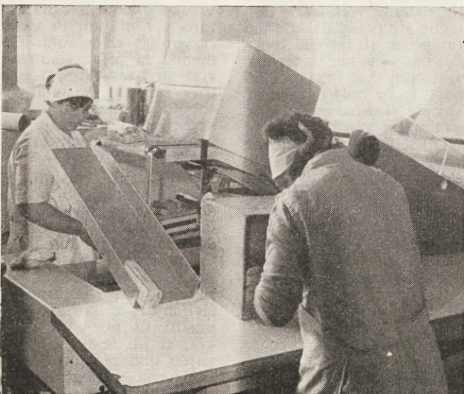
Avtomatični zavijalni stroj opravi skoraj vse delo sam. Delavke le pazijo na njegovo delovanje in zlagajo izdelke v embalažo
