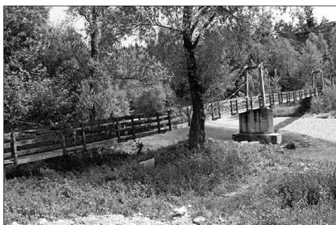
Na mestu, kjer je sedaj brv, bo zgrajen nov most. (Foto: Marija Lebar)
