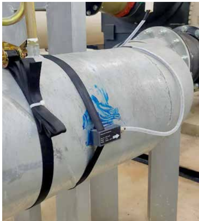
Slika 5 : Sonda pretoka nameščena na cev večjega premera
