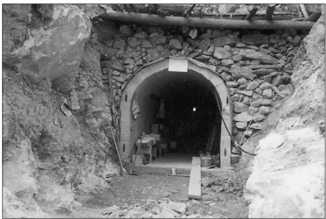
Vhod v nekdanji bunker na Zgornji Bistrici
