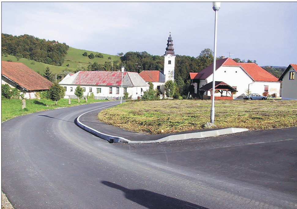
Obnovljena cesta s pločnikom od cerkve do pokopališča
