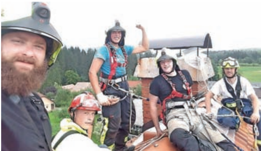
Glavna naloga je bilo začasno prekrivanje uničenih streh na objektih.
