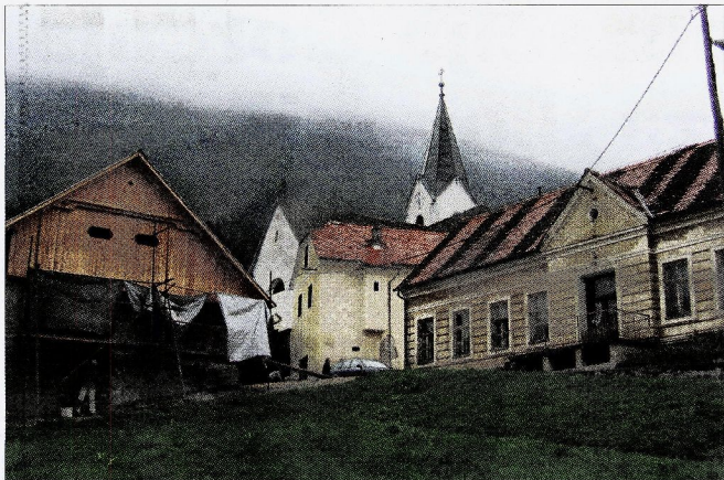
Ob vseh praznih stavbah najbolj bodo v oči odslužena osnovna šola. Ostale so vsaj obnovljene ...
