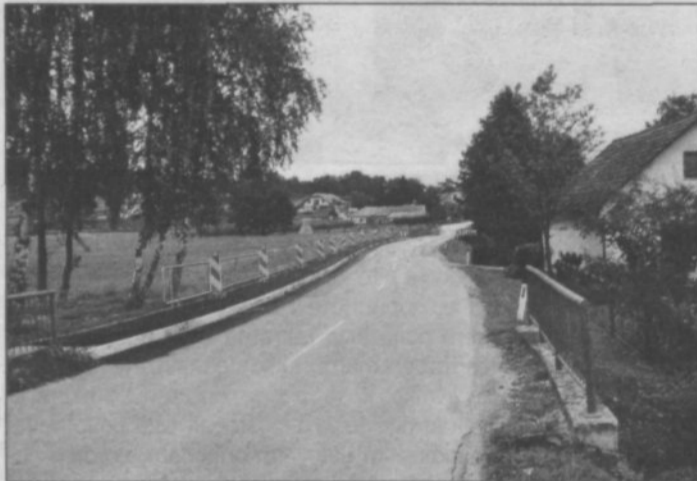
Pločnik in postavljena ograja
