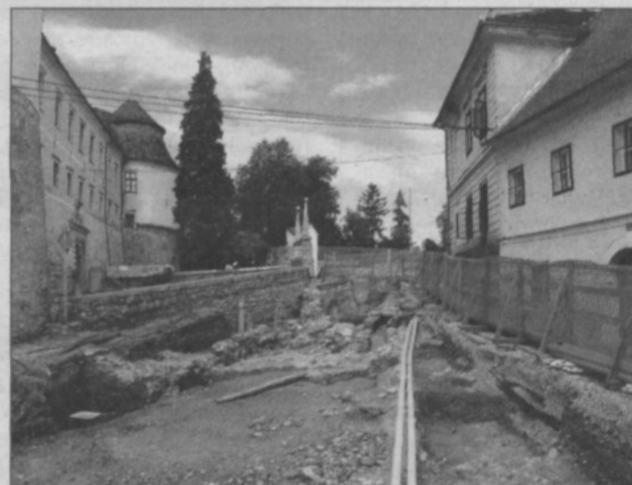
Izkopavanja ob brežiškem gradu
