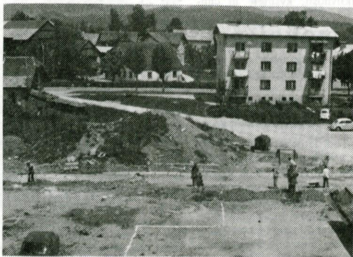
Komunalno urejanje površin v stanovanjski soseski na „Furlanovem“, kjer bodo nastale nove asfaltirane poti, parkirišča in zelenice.
