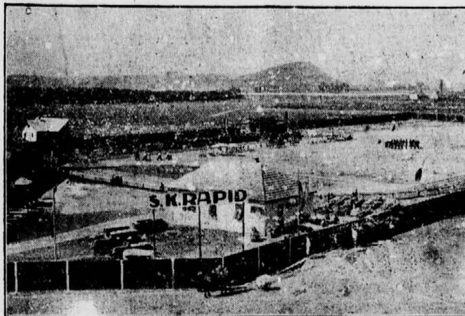
Die neue Sportanlage
