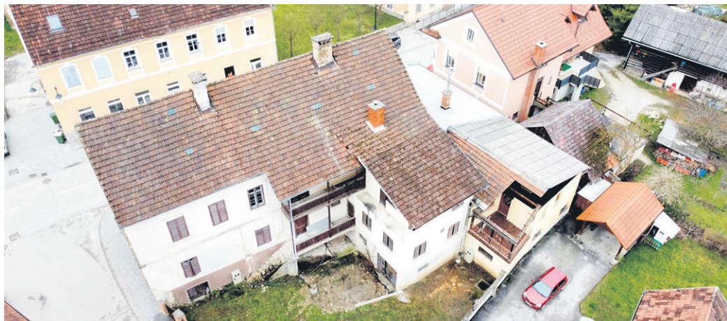
Nova stavba s sedmimi stanovanji bo nadomestila Mačkovo hišo, ki je statično ogrožena. (Foto: Občina Kozje)
