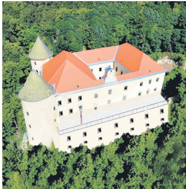
Na gradu bo kmalu spet gradbišče. (Foto: Občina Podčetrtek)
