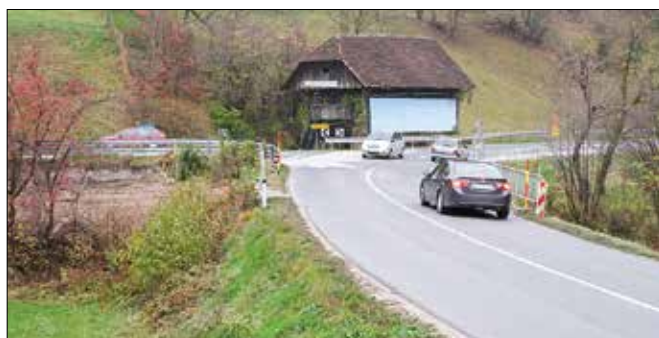
Z odstranitvijo starega objekta tik ob križišču je vidljivost sedaj večja. (Foto: Benjamin Kanjir)
