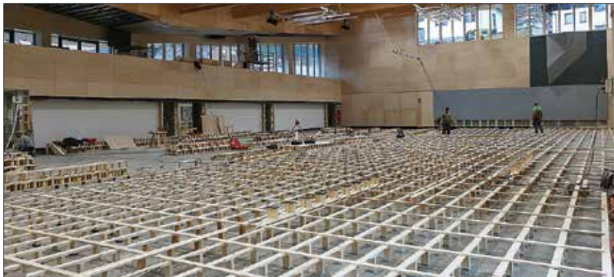
V športnem centru poteka polaganje spodnjega ustroja tako imenovanega športnega poda. (Fotodokumentacija Občine Luče)
