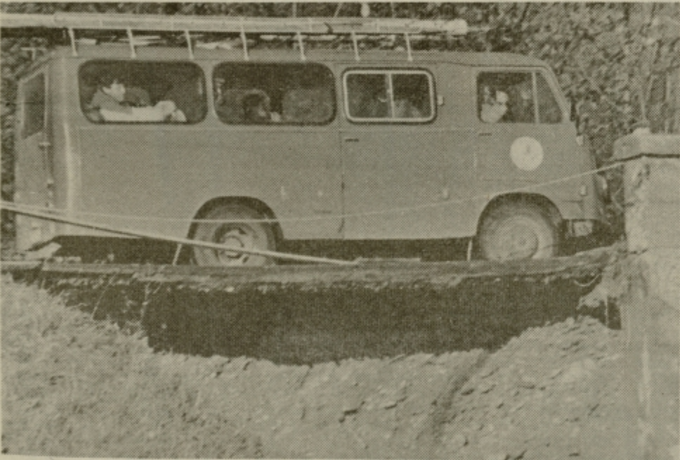
Vzdrževalne ekipe so se s težavo prebijale do poplavljenih območij.
