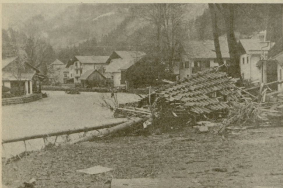
Podivjana Lučnica je s sabo odnašala vse, niti za trenutek ni izbirala. Hkrati pa je nanašala. Takih razdejanj so Luče polne. Ostanke streh, hiše, ki so še vedno v nevarnosti, vzbujajo v Lučanih še večji strah, grozo in negotovost.
