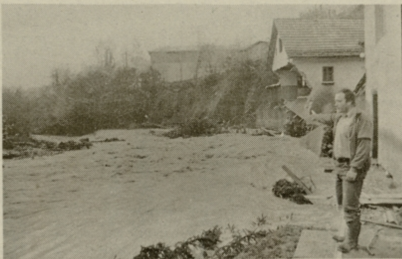
Marjan Rakun kaže na mesto sredi spremenjenega toka Ljubnice, kjer je še dan prej stala njegova nova hiša. Na desni so ostanki stare hiše, ki jo je tudi odtrgalo.
