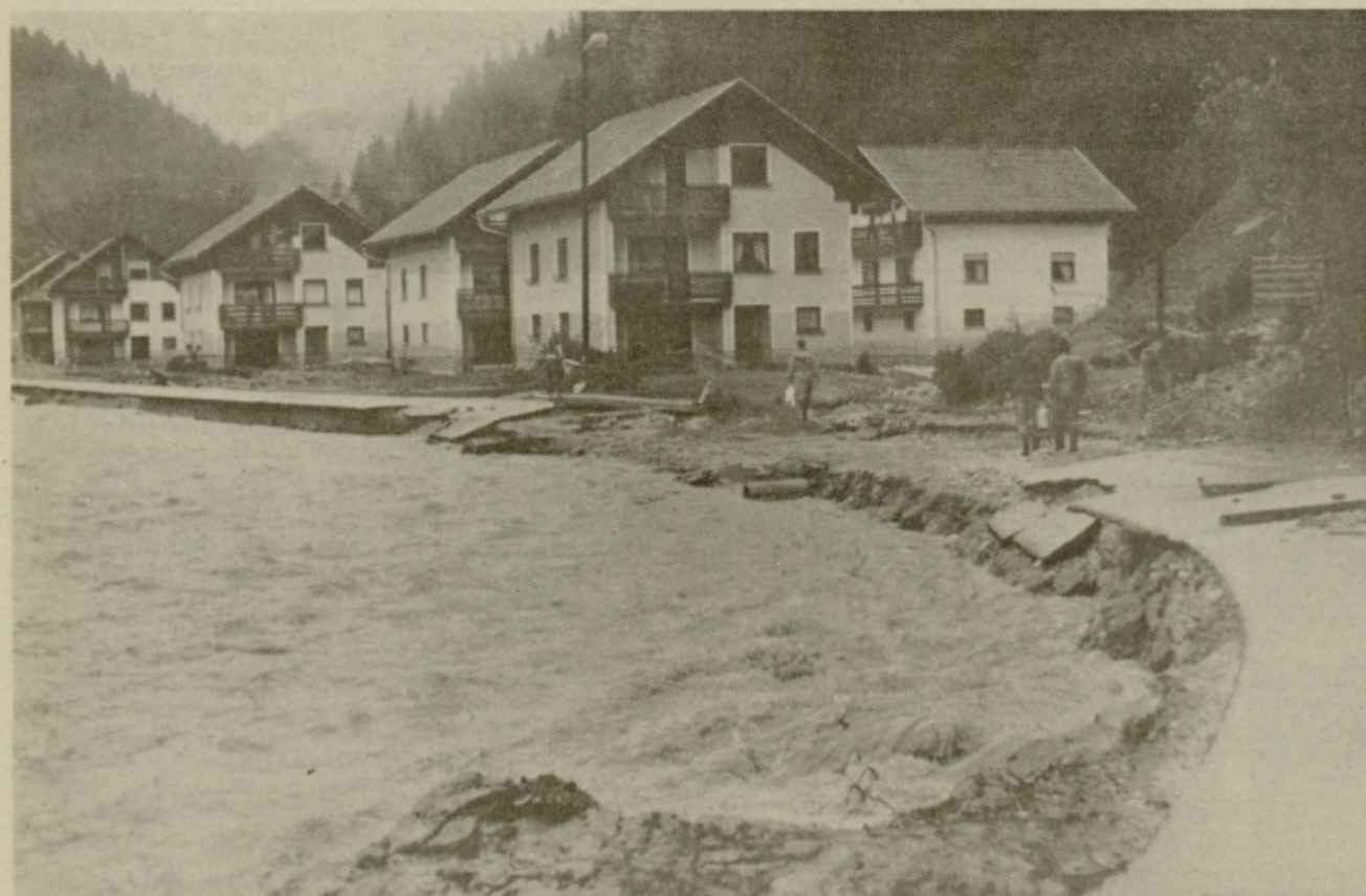
Nekoč je bila tudi asfaltna cesta, ki je vodila iz Luč v 9 kilometrov dolgo dolino Podvolovljek. Lučnica je odnesla dele asfalta s sabo. Na hišah se razločno vidi, do kod je segala voda.
