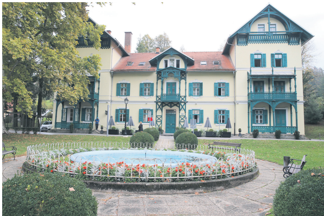
Novo podobo in vsebino te dni dobiva hotel Park, nekdanji Švicarski dvor, ki so ga na Dobrni zgradili leta 1872. Prenova bo končana zelo kmalu. (Foto: Andraž Purg)
