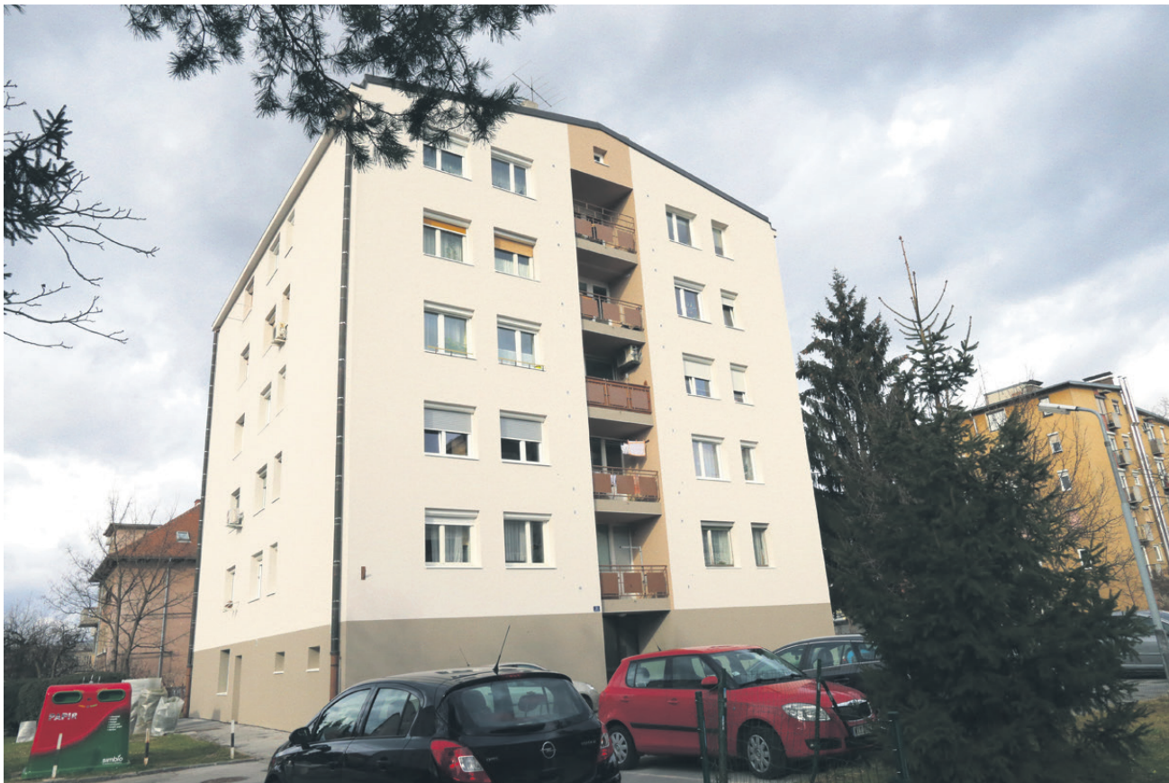
Stavba v Brodarjevi. Delilniki na radiatorjih so. A nedelujoči.
