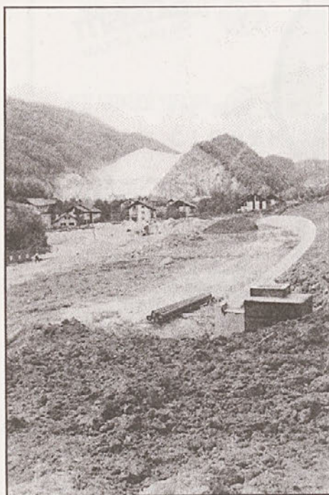
Ogromno zemeljskih del so opravili (foto B. Nimac)
