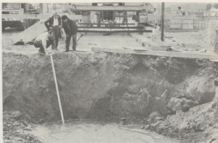
Izkopi za temelje na osnovi katerih se je pokazalo, da je zaneslivejša temeljitev večjega dela gradbišča s piloti
