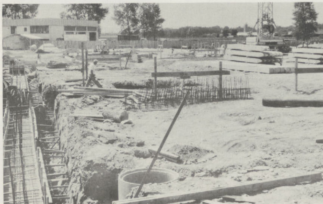
Začetek gradnje temeljev. Desno vidimo pilote za temeljitev
