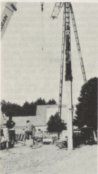
Zabijanje pilotov za temelje
