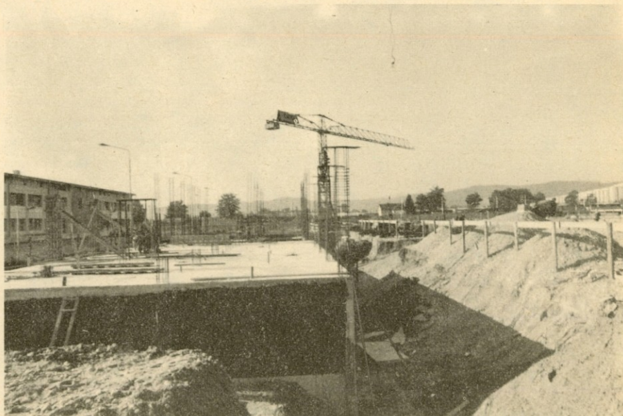
Ob novem raste novo - posnetek z gradbišča Kartonazne Ljubljana v Mostah.
