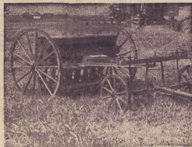
Tovarna OLT v Osijeku izdeluje sejalnike za žito, in to 12-, 14- in 16 vrstne. Pri njih je potreben le par vprežne živine in dva človeka. Dnevno poseje od 4 do 8 hektarov.
