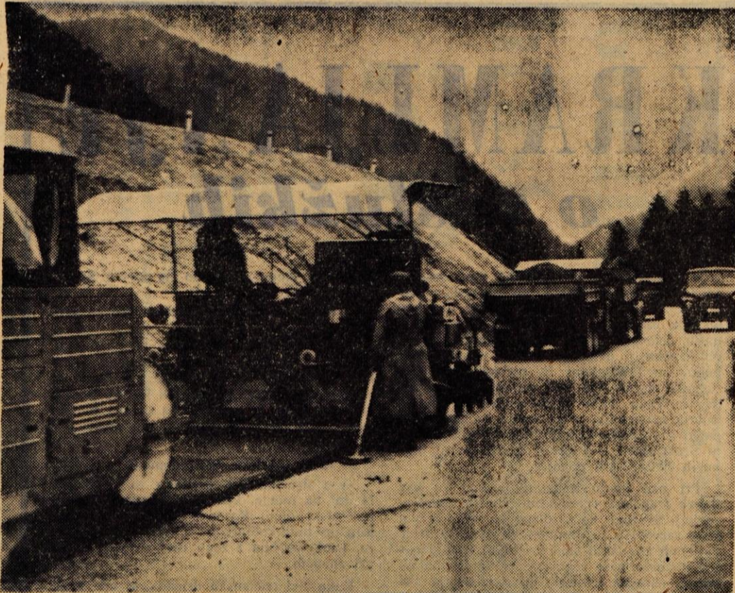
Nova Ljubeljska cesta bo imela dve plasti grobege asfalta, na kateri bodo položili še plast fine površine. Na odsekih cest, ki so že zgrajeni, sta položeni že obe spodnji plasti, tako da je vožnja po njih sedaj mogoča.
