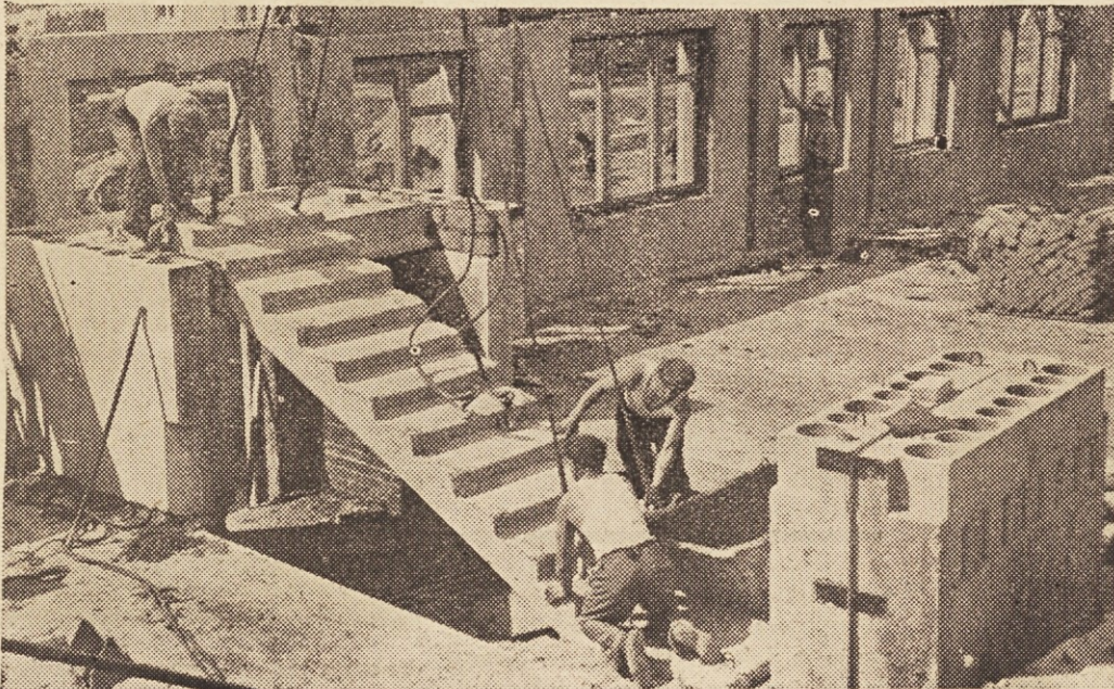
Pogled na stavbo polmontaže v Moskvi
