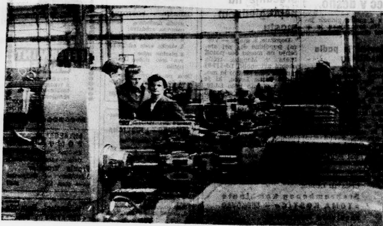
PRVA DOMAČA TRANSFER LINIJA ali obdelovalna proga je bila montirana v tovarni TAM, kjer jo uporabljajo za obdelavo glav valjev motorja. Polna zmogljivost te naprave v 8 urah je okrog 300 motornih glav. Vpliv delavca pri polavtomatski napravi je omejen zgolj na pravilno vpetje glave, vse ostalo opravi s skrajno preciznostjo stroji.
