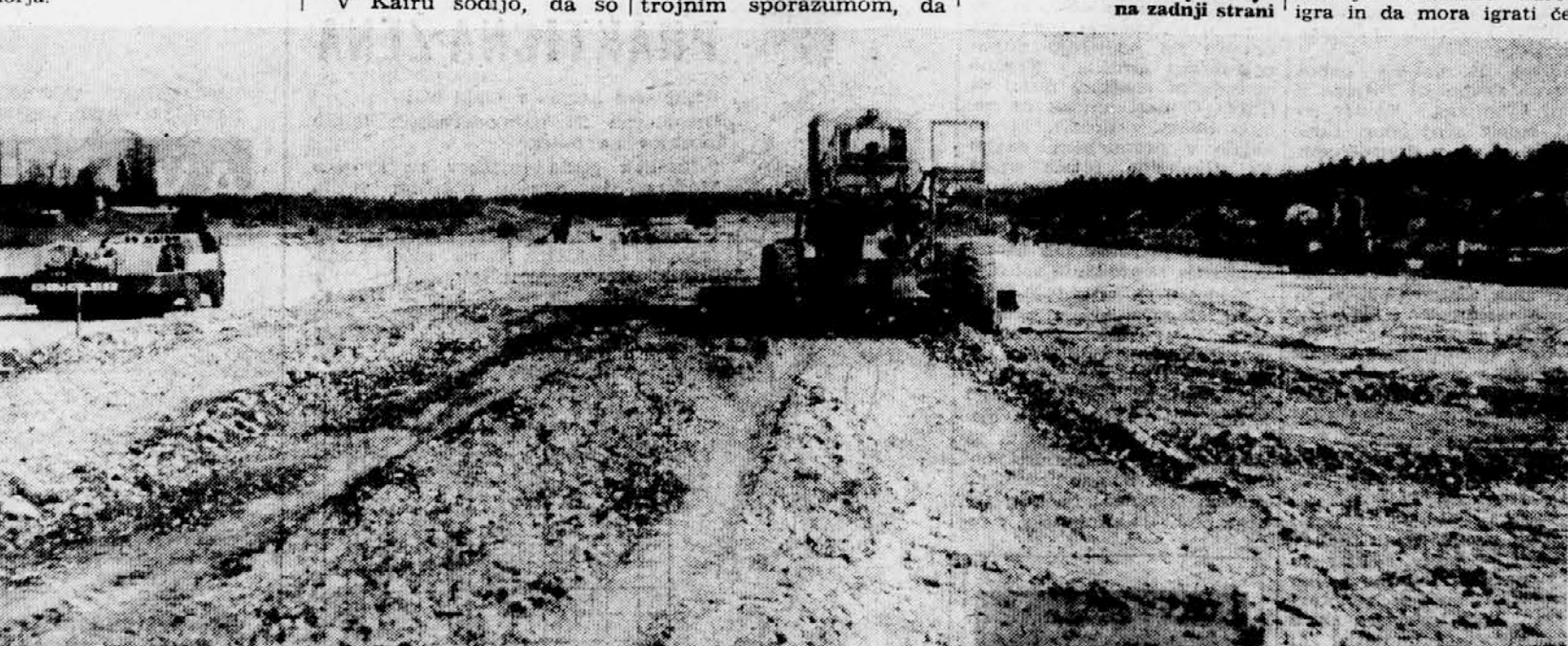
NOVO LJUBLJANSKO LETALIŠČE v Brnikih pri Kranju bo usposobljeno za promet letos jeseni. Zdaj je to eno največjih in po mehanizaciji najmočnejših gradbišč sezona v naši republiki. V 2200 metrov dolgo in 45 metrov široko vzletno stezo bodo vgradili 25.000 kubičnih metrov gramoz, ki ga bodo pripeljali iz gramoznice pri Mengšu, kjer so v ta namen postavili posebno separacijo. Na sliki: strojno posadke podjetja »Slovenija ceste« pripravlja vzletno stezo. Foto: P. Strnad
