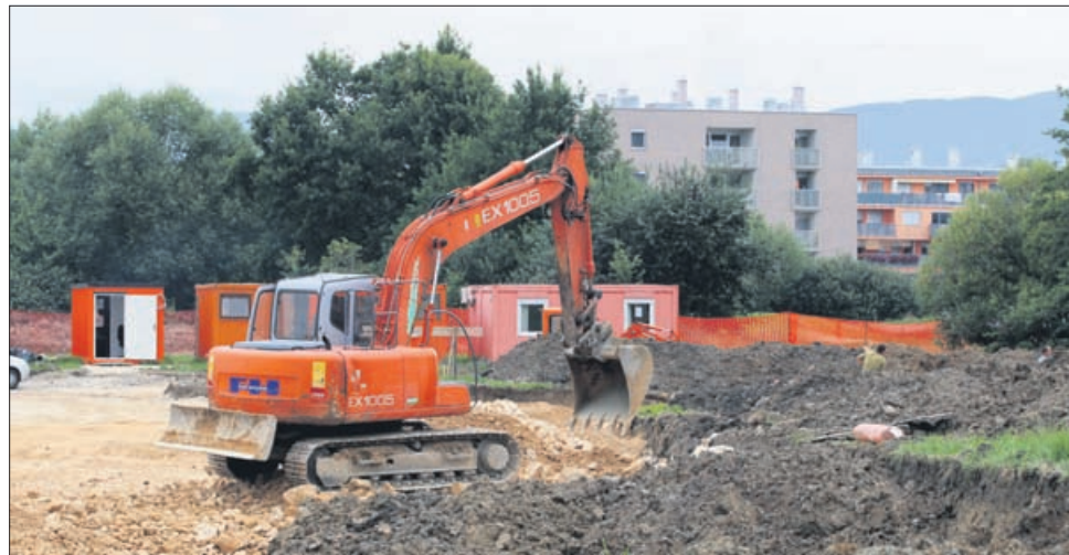
Zaenkrat delavci Konstruktorja še delajo na gradbišču novega celjskega vrtca.
