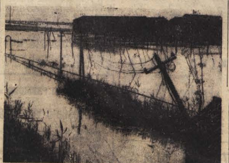
Na tisoče ljudi je moralo zaradi poplav v Padski nižini zapustiti domove. Pri Vendraminu je Pad podl obrambne nasipe, vode so zalile gosto naseljeno in dobro obdelano ravnino. Škoda znaša po površnih ocenah težke milijarde lir
