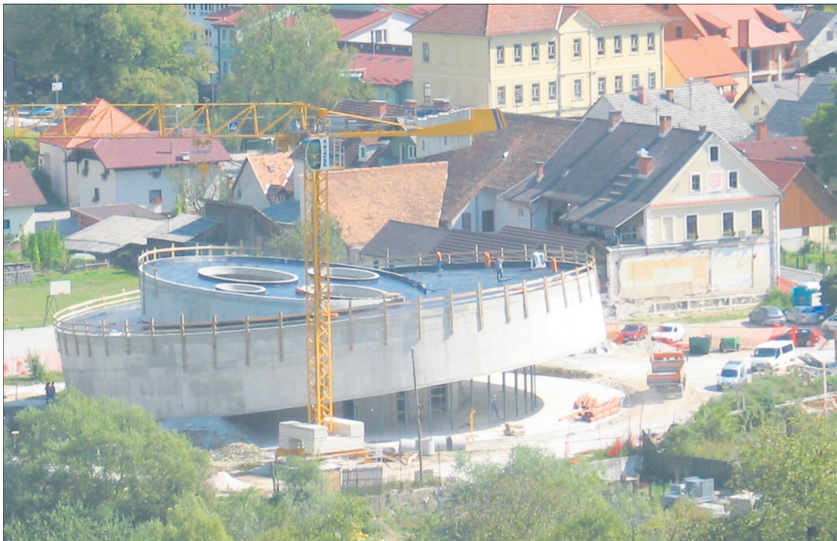
Kulturno središče evropskih vesoljskih tehnologij v Vitanju. Z gradbišča prestižne stavbe, ki jo Vitanjčani vidijo kot veliko razvojno priložnost.
