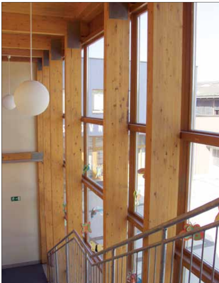
Ponovno uporabljeni lepljeni leseni nosilci za konstrukcijo evakuacijskega stopnišča
