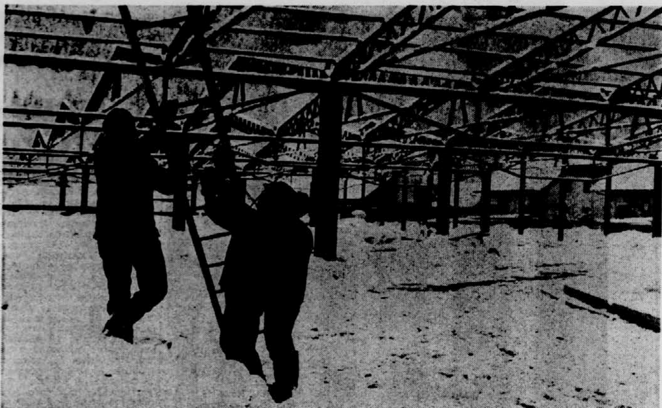
»ALPLES« IMA V ŽELEZNIKIH NOVO HALO — V kratkem času je v Železnikih zrasla pajčevinasta železna konstrukcija novega obrata »Alples«, kamor bodo čez nekaj mesecev preselili svojo proizvodnjo. Foto: Marijan Kregar
