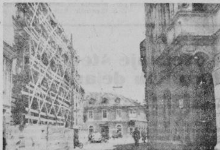
Opazi na ptujskih ulicah — obnavljajo fasade na glavnih hišah
